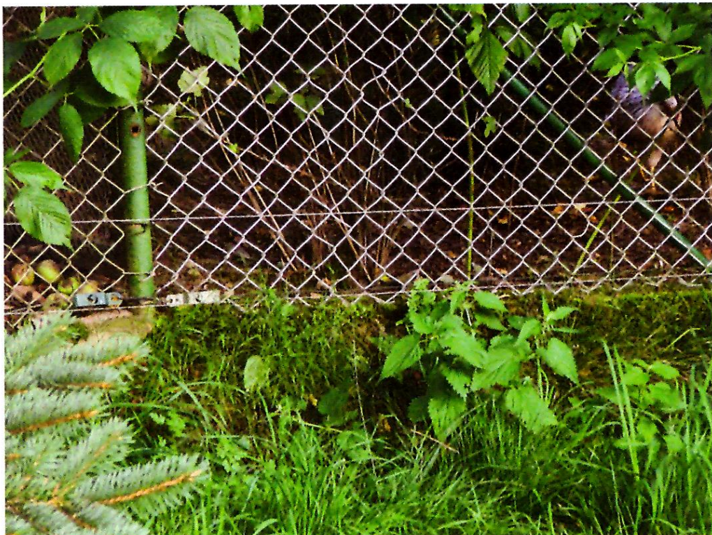
Zwei bodennah angebrachte stromführende Drähte verhindern das Eindringen von vierbeinigen Räufern
